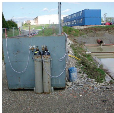
Exemple de traitement des eaux de chantier par décantation, séparation et neutralisation.
